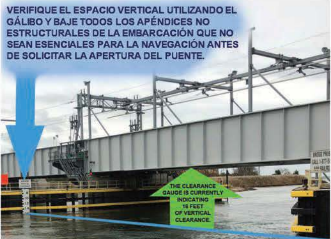
CALADO DE AIRE = DISTANCIA DESDE LA LÍNEA DE FLOTACIÓN HASTA EL PUNTO MÁS ALTO DE LA EMBARCACIÓN
